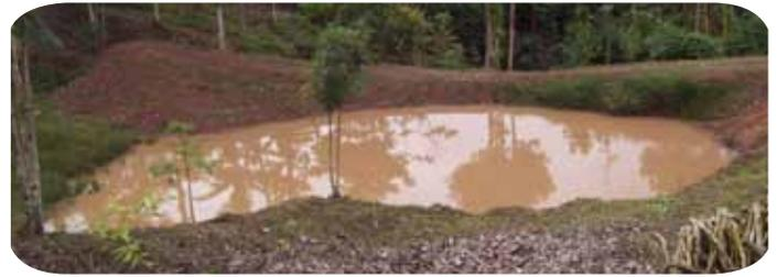
Foto 8. Laguneta con revestimiento de arcilla
