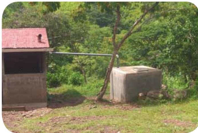
Foto 2. Sistema de captación de agua de techo
