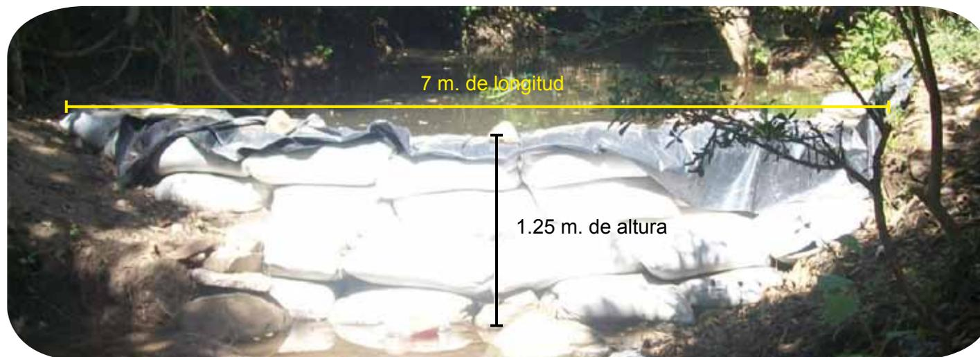
Foto11. Dimensiones del muro de retención de sacos con arena y plástico
