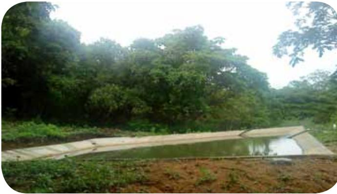
Foto 3. Reservorio revestido con material ciclópeo
