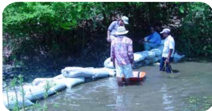
Foto 10. Micro presa desmontable de sacos de arena y plástico
