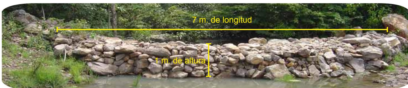
Foto 13. Dimensiones del muro de retención con piedra bolón
