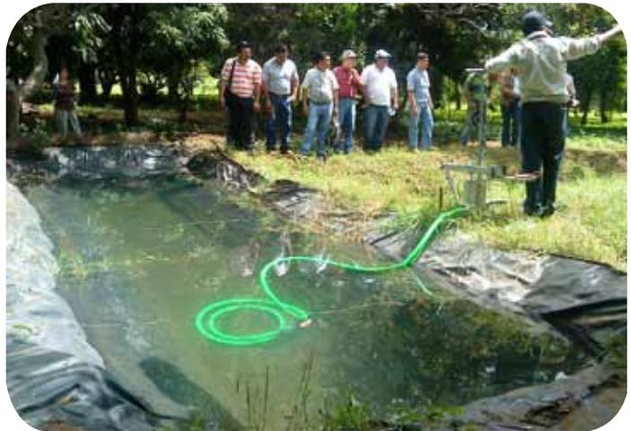
**Foto 4. Reservorio revestido con plástico**
