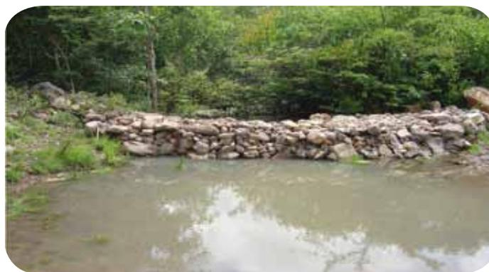
Foto 12. Micro presa desmontable con piedra bolón
