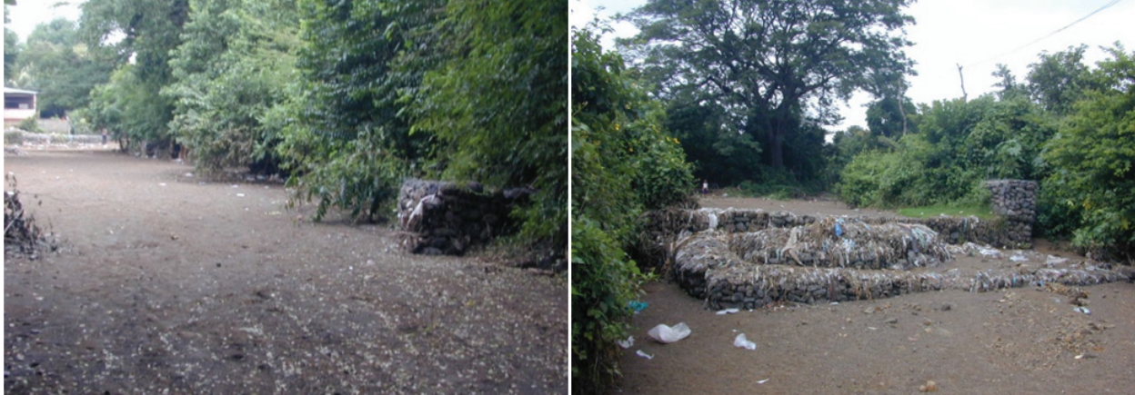
Figura IV.16. La figura muestra dos imágenes de los cauces que atraviesan la ciudad de Managua a la llegada de cada invierno.
