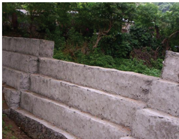
Figura V.9.a. Ejemplo de dissipador de energía de las corrientes de agua. (Fuente POSAF-MARENA)
