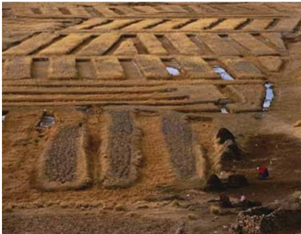
Figura V.5.a. Construcción de surcos para la captación de agua..
