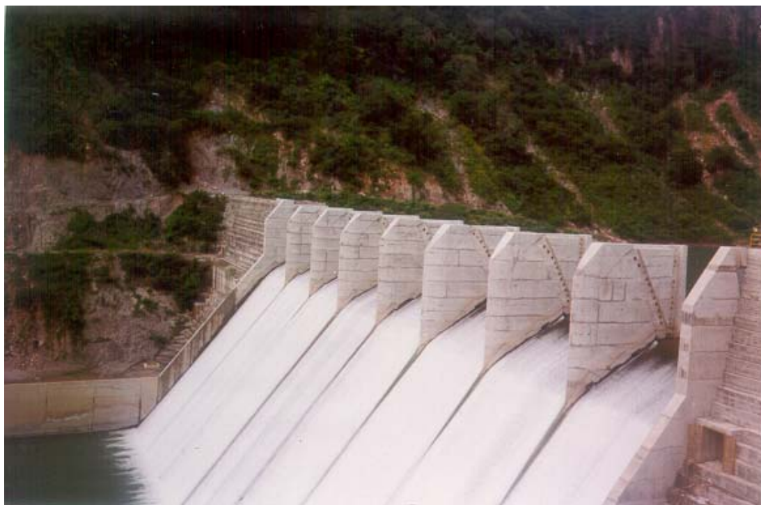
Figura 141. Presa de Nacaome
