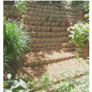
Obras biomecánicas realizadas con las comunidades para la estabilización de los terrenos
