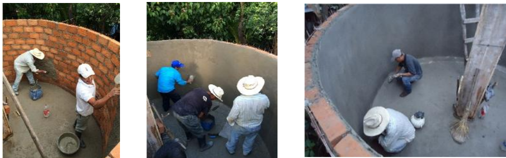
Instalación del muro capuchino con acabados
