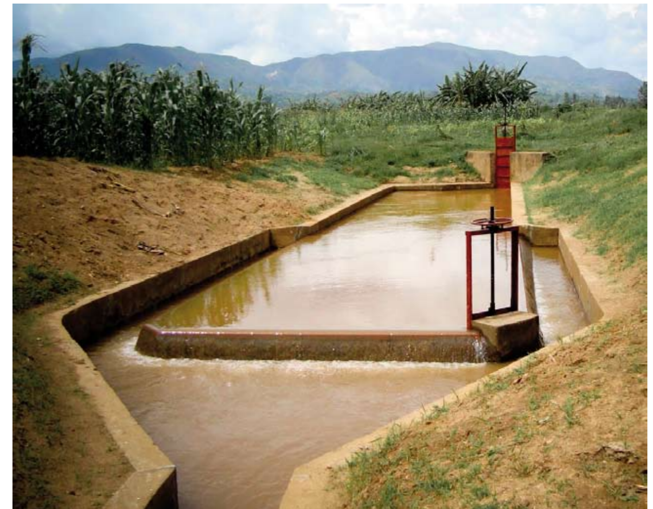
Dessableur du barrage de Nyembwika, 2009 Financement Belgique
